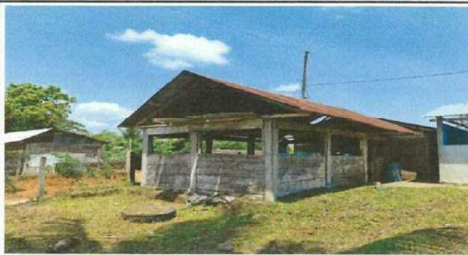
Foto 3: MEJORAMIENTO DE COCINA EN SU TOTALIDAD, CON BLOCK
