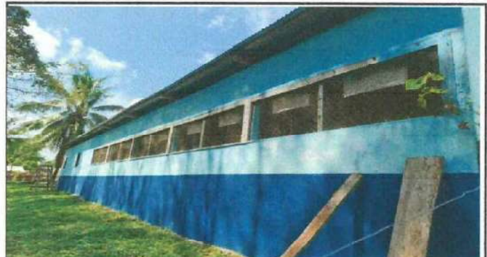
Foto 2: SUSTITUCION DE VENTANAL DE MADERA, PARTE FRONTAL
